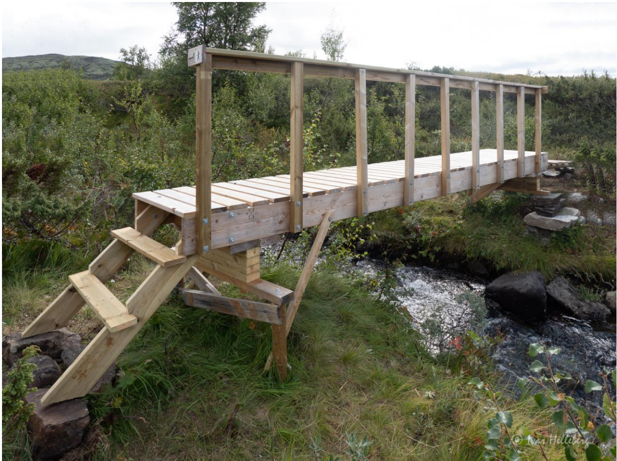
FORSTERKET BRU PÅ STIEN MOT SPRENHØA
